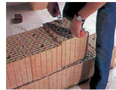
4 | Verlijmen met dompeltechniek
