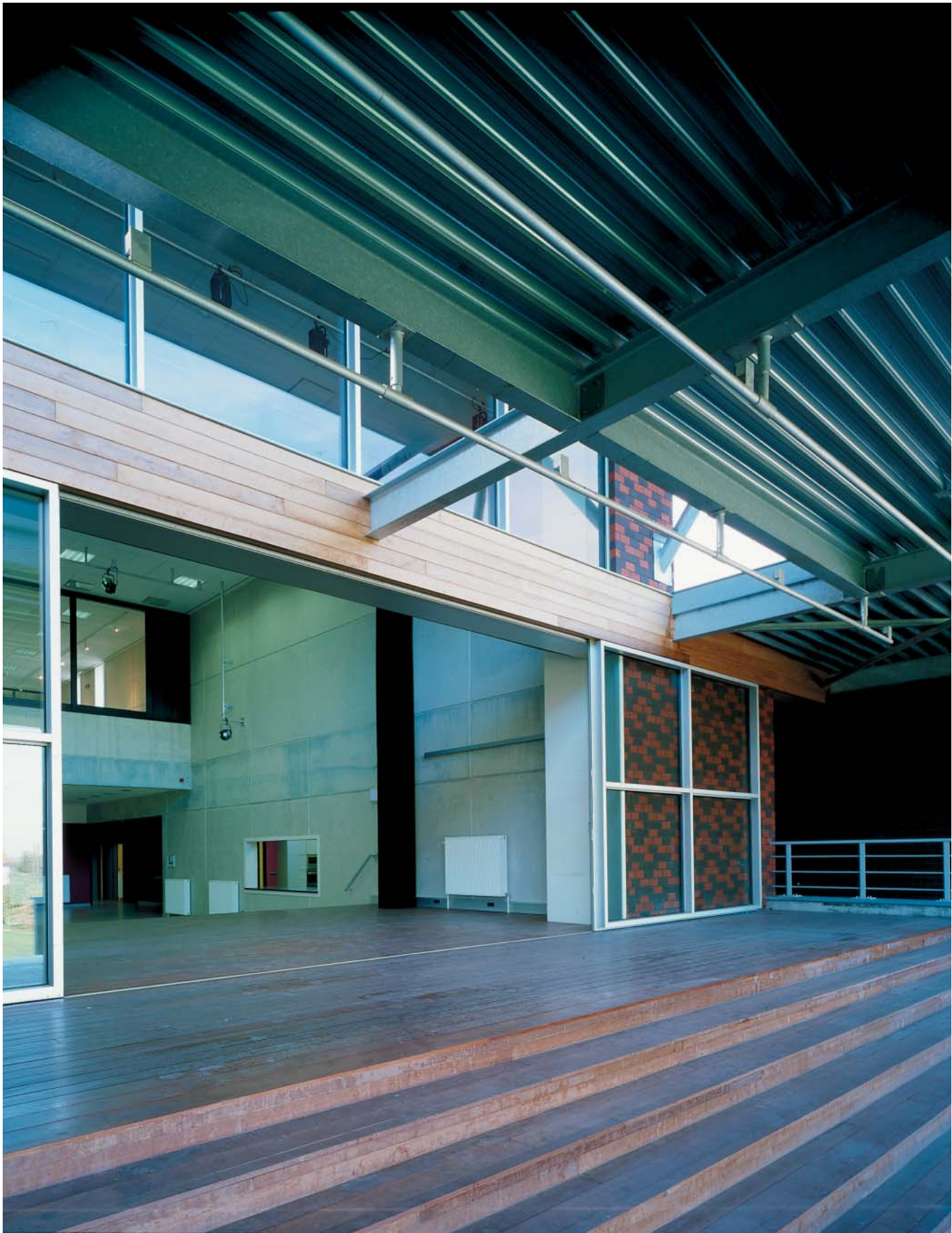
11 | Door het openen van een groot schuifraam kan het podium zowel voor binnen- als voor buitenactiviteiten worden gebruikt
