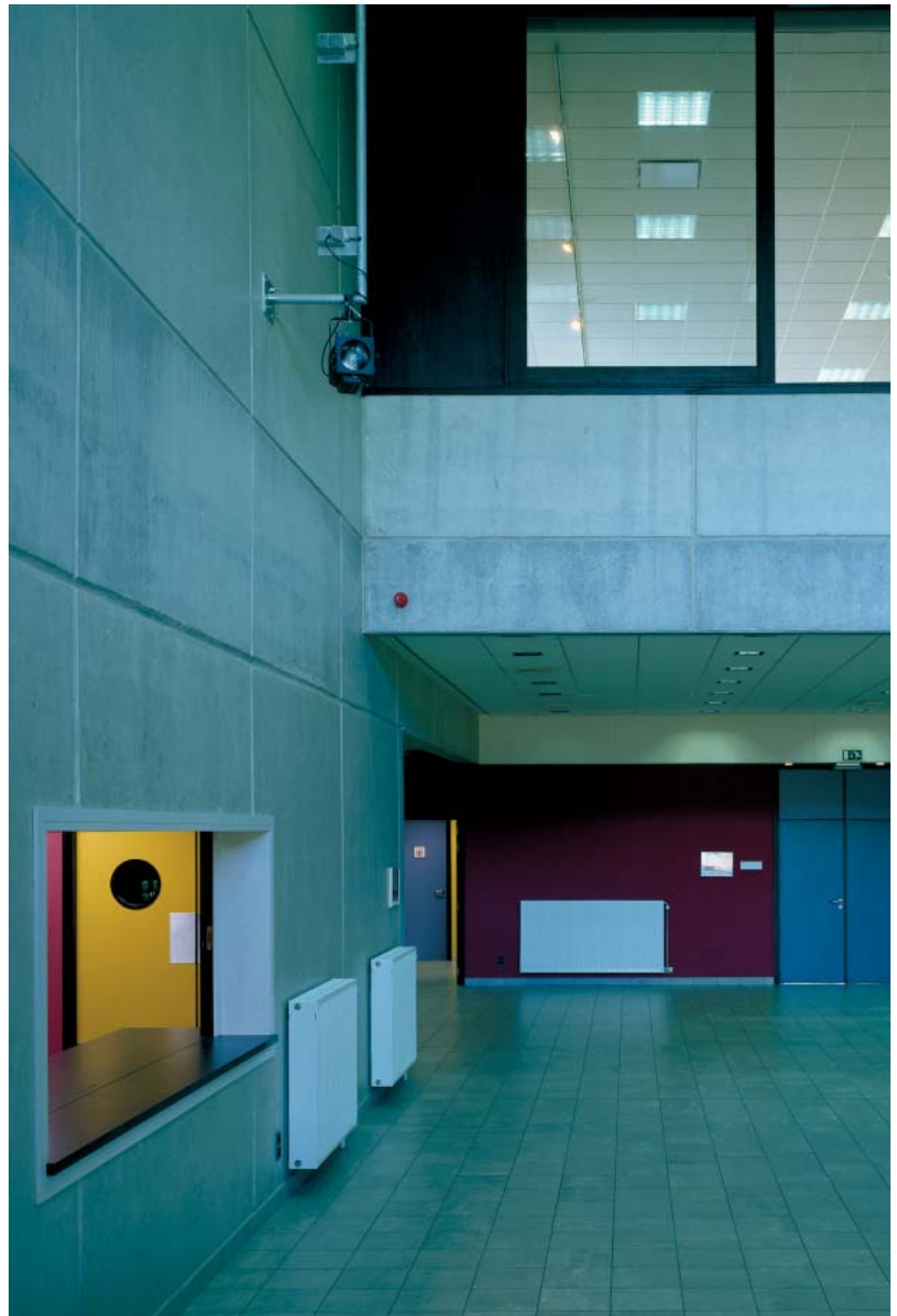
8 | Ontmoeting van in het werk gestort beton en prefab hollewandelementen
