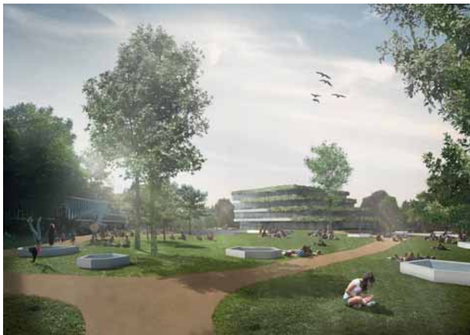
De bovengrondse verdiepingen hebben elk een groendak op het uitkragende deel.
